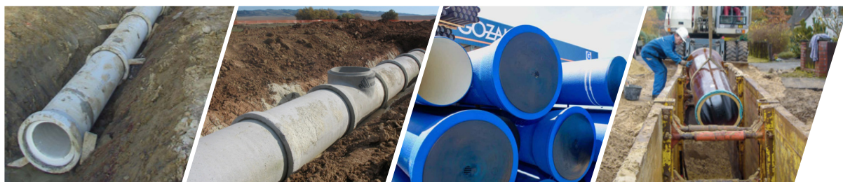
1) Coletor de betão em massa; 2) Coletor de betão armado; 3) Coletor de fundição dúctil; 4) Coletor de grés vitrificado
